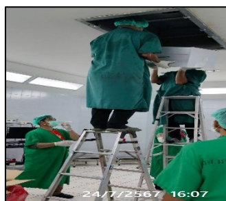
ภาพที่ ค-4 ทำความสะอาดเครื่องปรับอากาศและทำการเปลี่ยน HEPA Filter ระหว่างเดือนกรกฎาคม - ธันวาคม 2567
