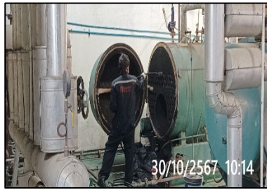
ภาพที่ ค-5 การตรวจสอบและบำรุงรักษาเครื่องจักรต่างๆ และบำรุงรักษาท่อระบายความร้อนระบบปรับอากาศ ระหว่างเดือนกรกฎาคม - ธันวาคม 2567
