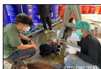
ภาพที่ ค-12 ตรวจสอบการทำงานของเครื่องเติมอากาศ และตรวจสอบสายไฟของระบบบำบัดน้ำเสีย ระหว่างเดือนกรกฎาคม - ธันวาคม 2567
