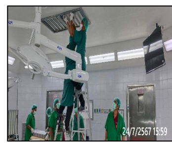
ภาพที่ ค-4 ทำความสะอาดเครื่องปรับอากาศและทำการเปลี่ยน HEPA Filter ระหว่างเดือนกรกฎาคม - ธันวาคม 2567
