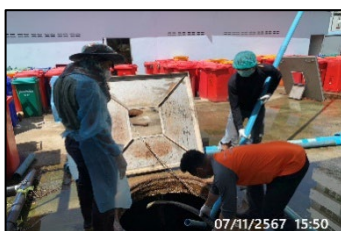
ภาพที่ ค-12 ตรวจสอบการทำงานของเครื่องเติมอากาศ และตรวจสอบสายไฟของระบบบำบัดน้ำเสีย ระหว่างเดือนกรกฎาคม - ธันวาคม 2567
